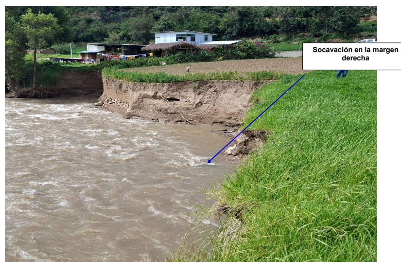
FIGURA N° Socavación en la margen derecha del RÍO CAJAMARCA (RÍO CAJAMARQUINO).
